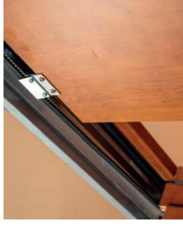
Dettagli installazione cinghia sul binario Belt installation details on the track
